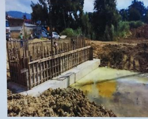
Şekil 9.1 A1 Kenar Ayak Beton Dökümü
