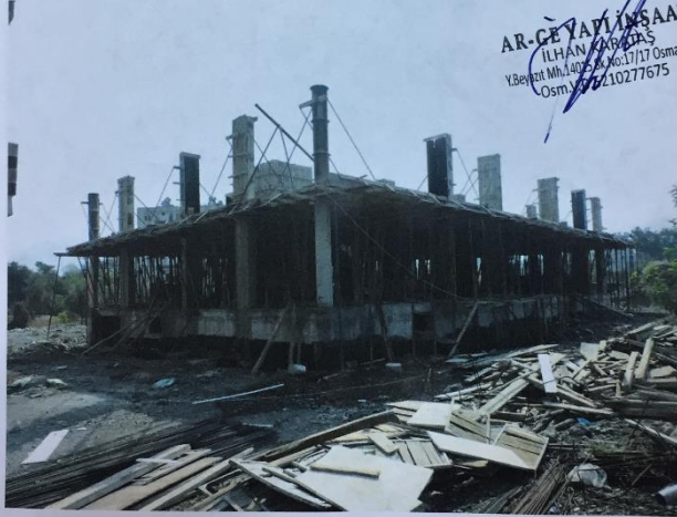
Sekil 4-Kolon ve aks yapımı
