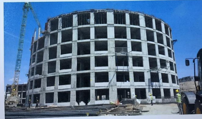
Şekil 1.2 Yapılan İnşaatın Genel Görünüşü
