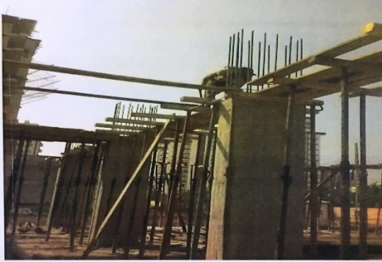
Şekil 7. DÖŞEME TAHTALARININ ÇAKILMASI
