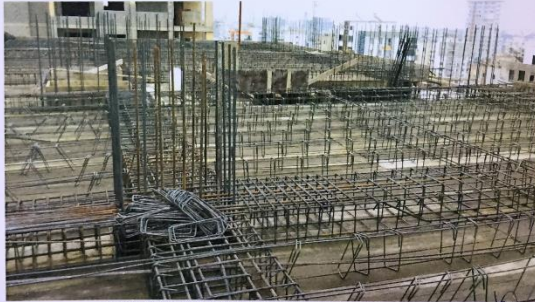
Şekil 7.1. DÖŞEME DONATILARININ YERLEŞTİRİLMESİ
