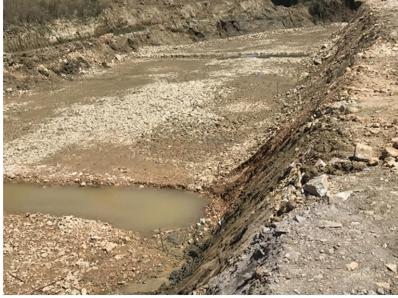
Şekil-35: Menfez gro beton sınırları
