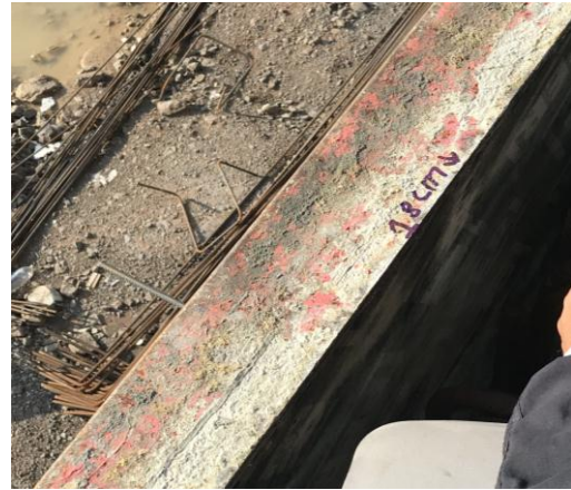
Şekil-10:Altgeçit döşeme kalıp
