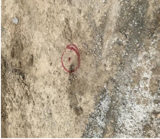
Şekil-20: Fore kazık noktası
