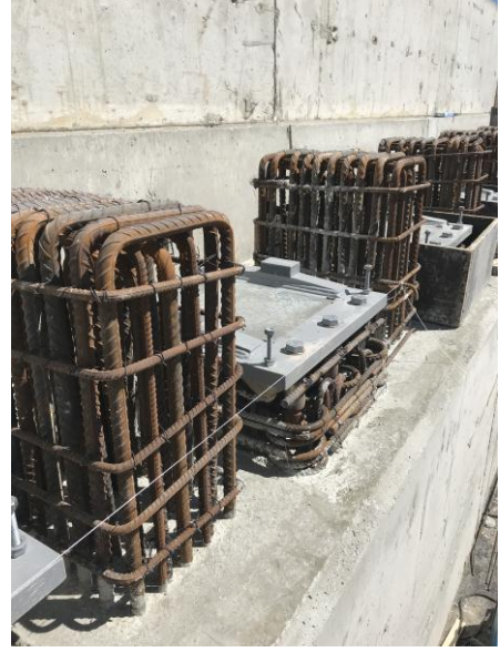
Şekil-31: deprem takozu ve mesnet
