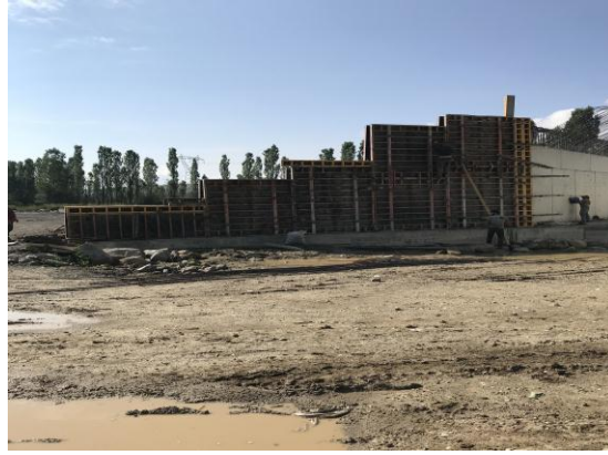
Şekil-11:Altgeçit kanat
