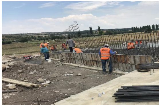
Şekil-12:Altgeçit kanat radyatemel
