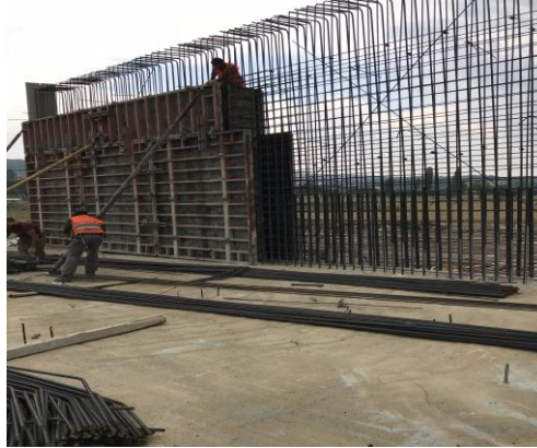
Şekil-18: Altgeçit perde kalıbı
