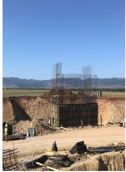
Şekil-39:Üstgeçit ayak perde kalıbı
