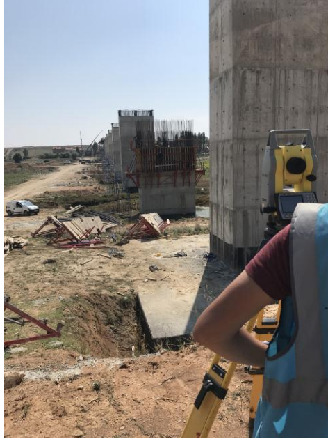
Şekil-16: Evelasyon kalıp
