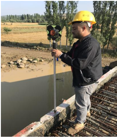
Şekil-9:Altgeçit döşeme kalıp
