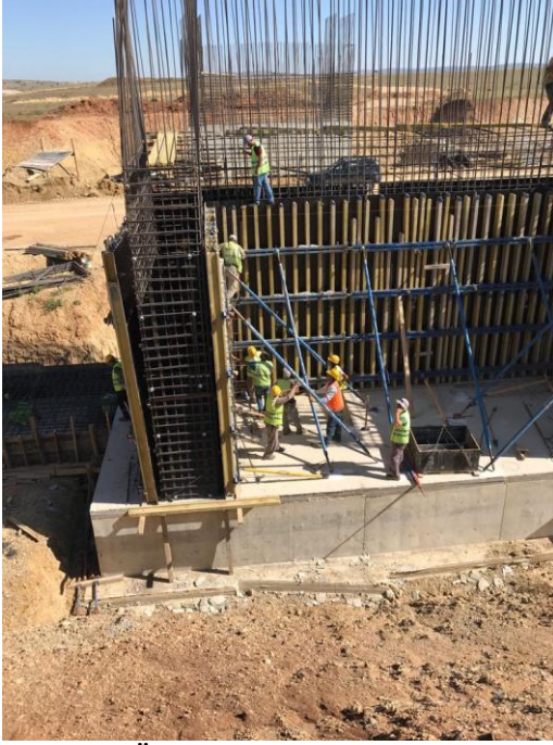
Şekil-38:Üstgeçit ayak perde kalıbı
